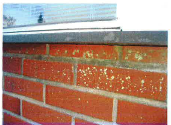
Kuva 6. Vesipeltien kallistukset eivät ole riittävät.
