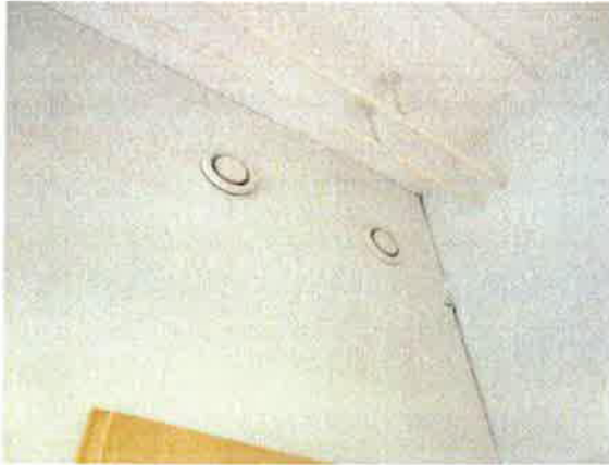
Kuva 53. Poistoilmaventtiili huoneessa.
