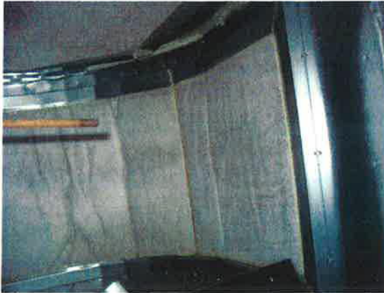
Kuvat 59 ja 60. TK5:n uusittuja äänieristeitä.
