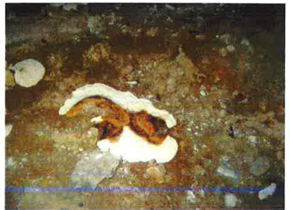
Kuvat 23 ja 24. Ryömintätilassa maanpinnalla sienikasvustoa.
