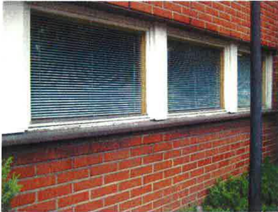
Kuvat 9 ja 10. Ikkunoiden puuosat ovat haristuneita.
