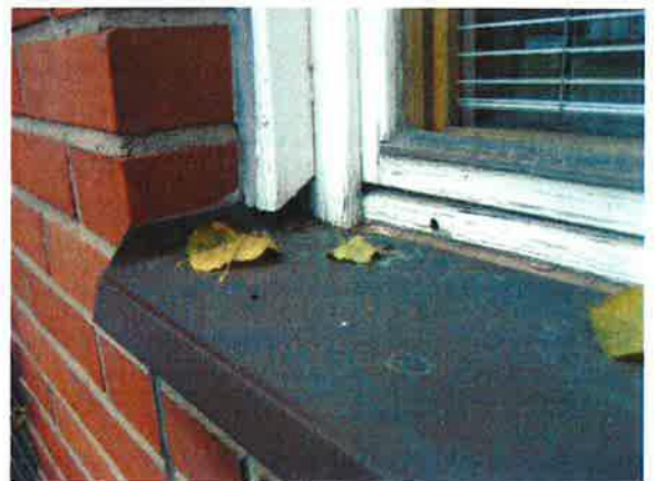
Kuva 6. Vesipeltien kallistukset eivät ole riittävät.
