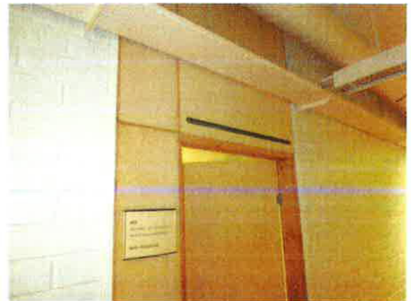
Kuva 52. Siirtoilmaventtiili huoneeseen.
