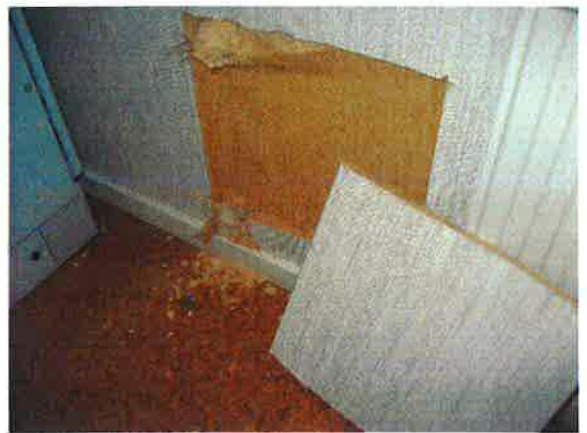
Kuva 40. Maanpainesinän akustiikkalevyä.
