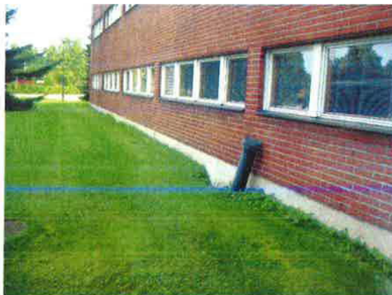
Kuvat 29 ja 30. Ryömintätilan tuuletus järjestetty yhdellä putkella.
