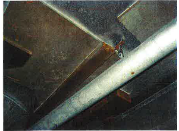
Kuva 48. Rakennusaikaisia muottilautoja.
