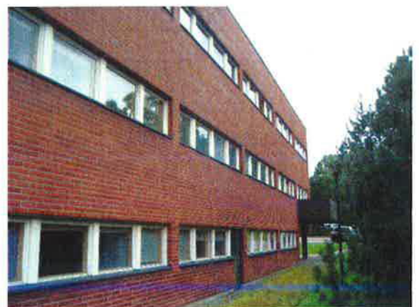
Kuva 2. B-siiven julkisivua länteen.
