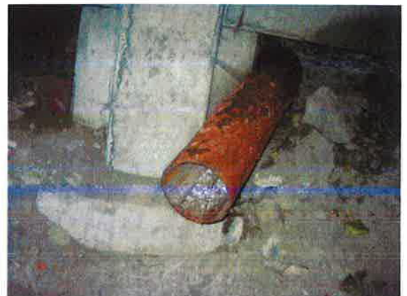
Kuvat 29 ja 30. Ryömintätilan tuuletus järjestetty yhdellä putkella.
