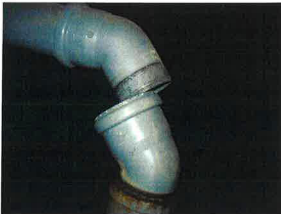
Kuva 27. Auennut LVI-putken liitos.
