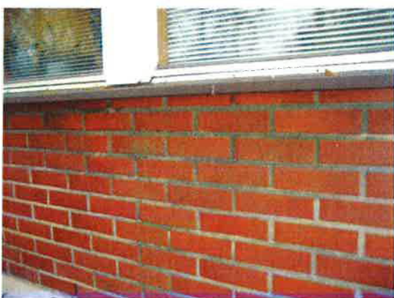
Kuvat 7 ja 8. Tummentumaa ja jäkälää ikkunoiden alla.
