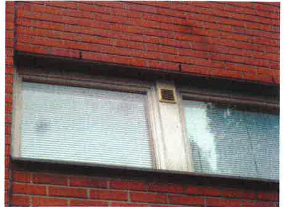
Kuva 54. Korvausilmaventtiili ulkoseinässä.
