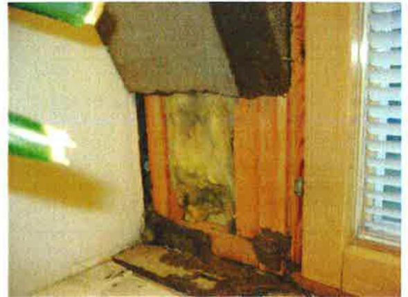
Kuva 12. Ulkoseinärakennetta aukaistuna.
