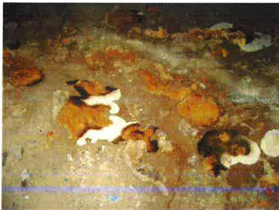
Kuvat 23 ja 24. Ryömintätilassa maanpinnalla sienikasvustoa.
