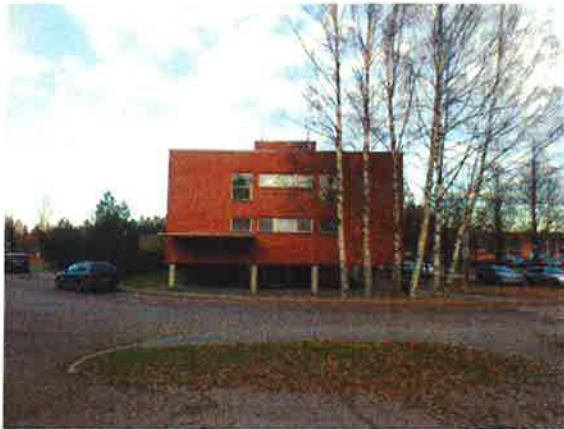
Kuvat 3 ja 4. B-siiven pääty etelään.
