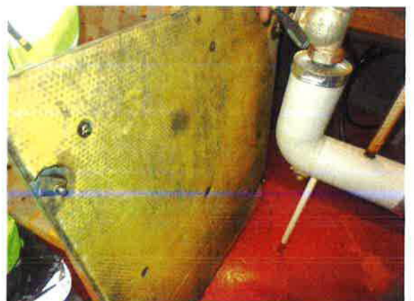
Kuva 56. Ilmanvaihtokoneissa pinnoitettua mineraalivillaa.
